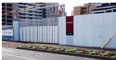
建設予定地には囲いができました。
